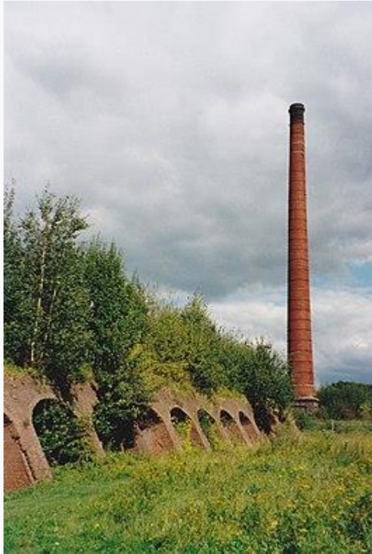
Ringoven en schoorsteen
